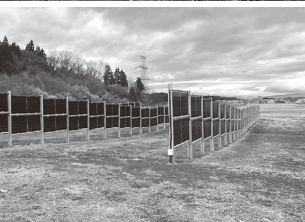
牧草畑に設置された垂直型ソーラーシェアリング。農作業がしやすく、朝と夕方に発電がピークとなり需要とマッチしています。（二本松市）
